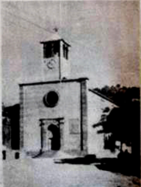
La Chiesa Matrice, sita nel centro del paese, dedicata a S. Atanasio il Grande, costruita verso la fine del 1400 recentemente restaurata.
