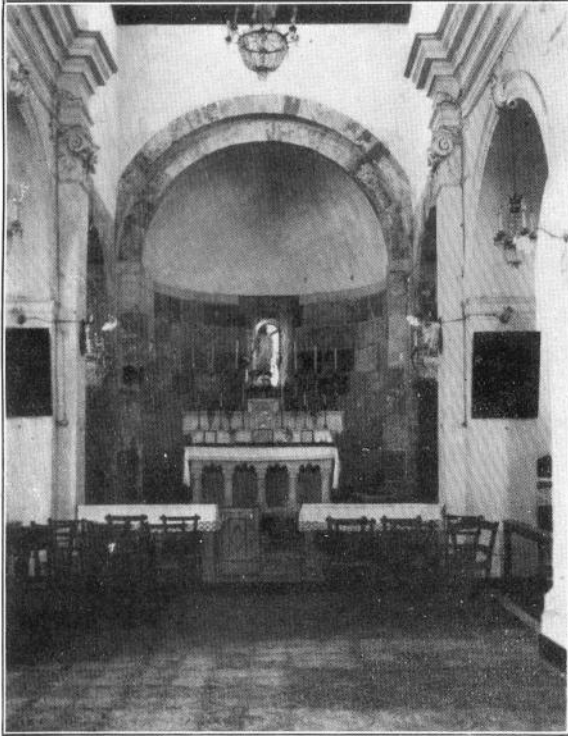
(Fig. 10) - Chiesa di S. Martino - Interno dell'abside dopo i restauri. Fot. dell'A.
