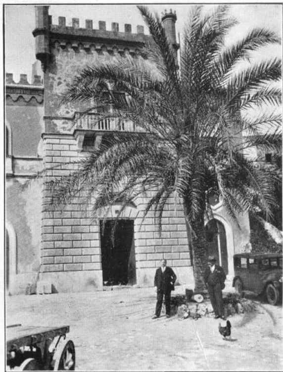
(Fig. 4) - Prospetto del Palazzo moderno sovrapposto a quello della basilica. La porta centrale corrisponde alla nave mediana, le due laterali alle piccole navate. Fot. dell'A.
