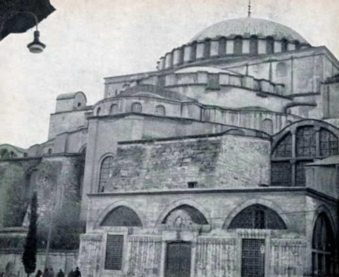
Esterno di S. Sofia di Costantinopoli.
