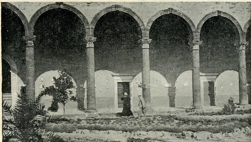
Grottaferrata. Badia. Portico del rinascimento.
