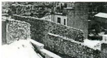
Resti di fortificazioni murarie con feritoie ora murate, del tipo di quelle esistenti in Kroja (Albania)
